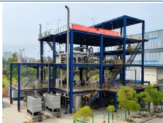
高温焚烧处理试验装置
