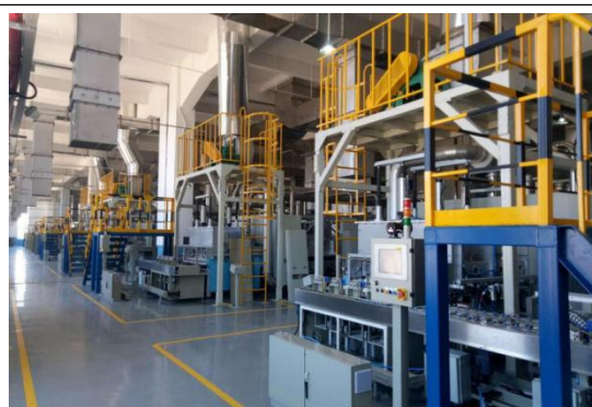
锂电智能生产线安装
